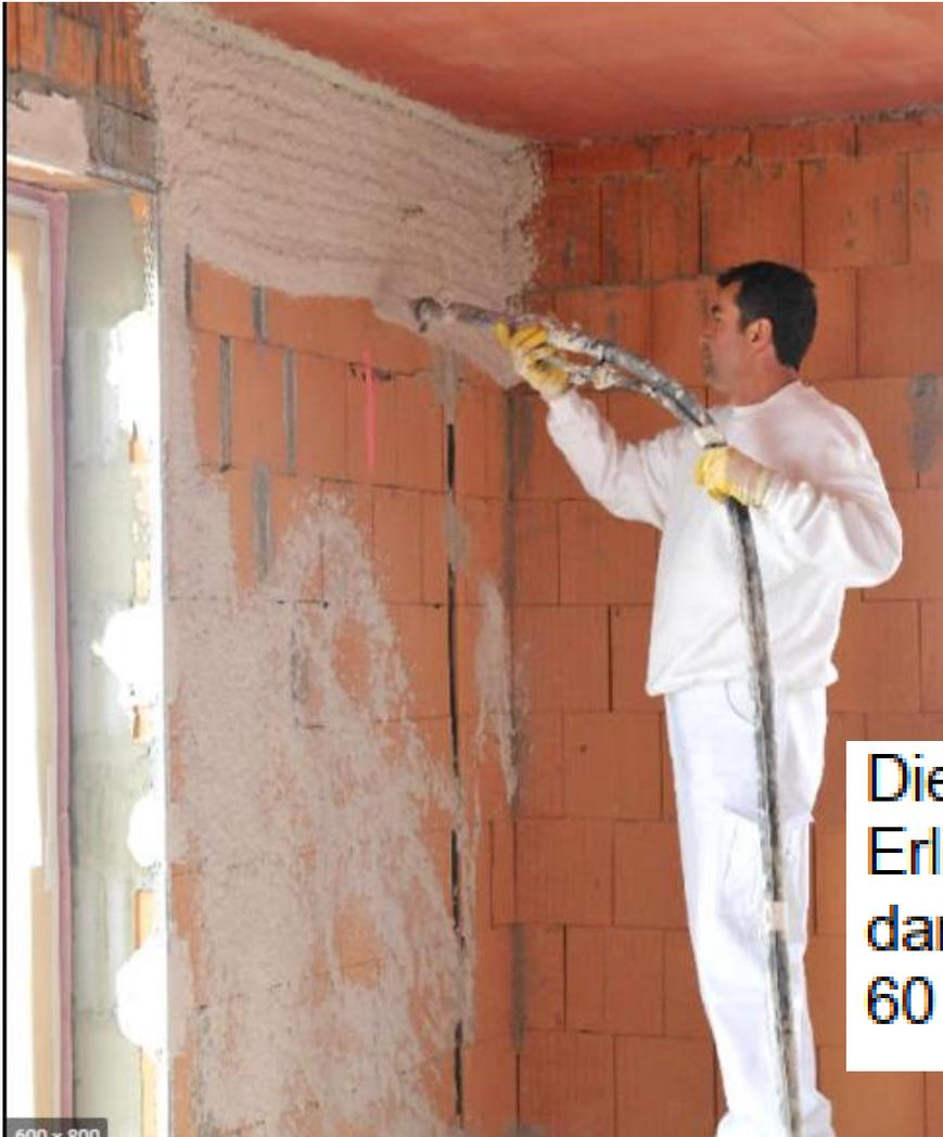
Die sulfatische Erhärtung kommt bereits bei + 5°C zum Erliegen. Diese Temperatur darf bis zur Aushärtung nicht darunter absinken und die Luftfeuchtigkeit darf 60 % nicht überschreiten.
